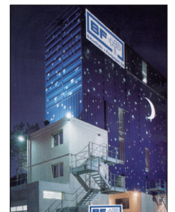
Habillage de façade Bétonfrais + Pompages (BF+P), Crissier
